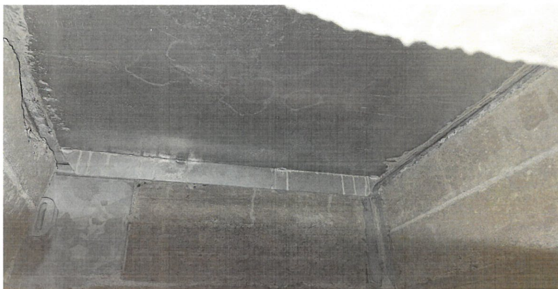
Obrázek 2: Zkouška vodotěsnosti – bez průsaku
